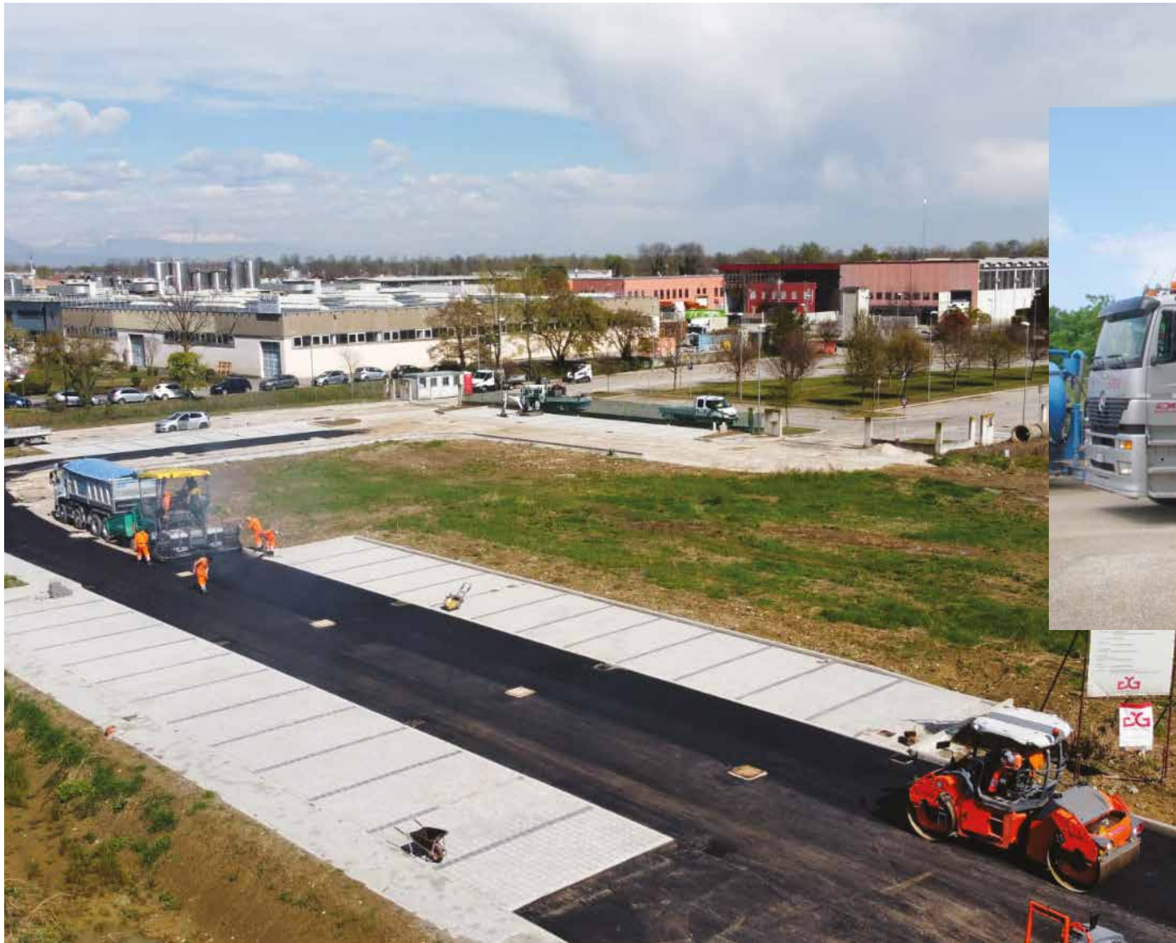
Opere di asfaltatura
